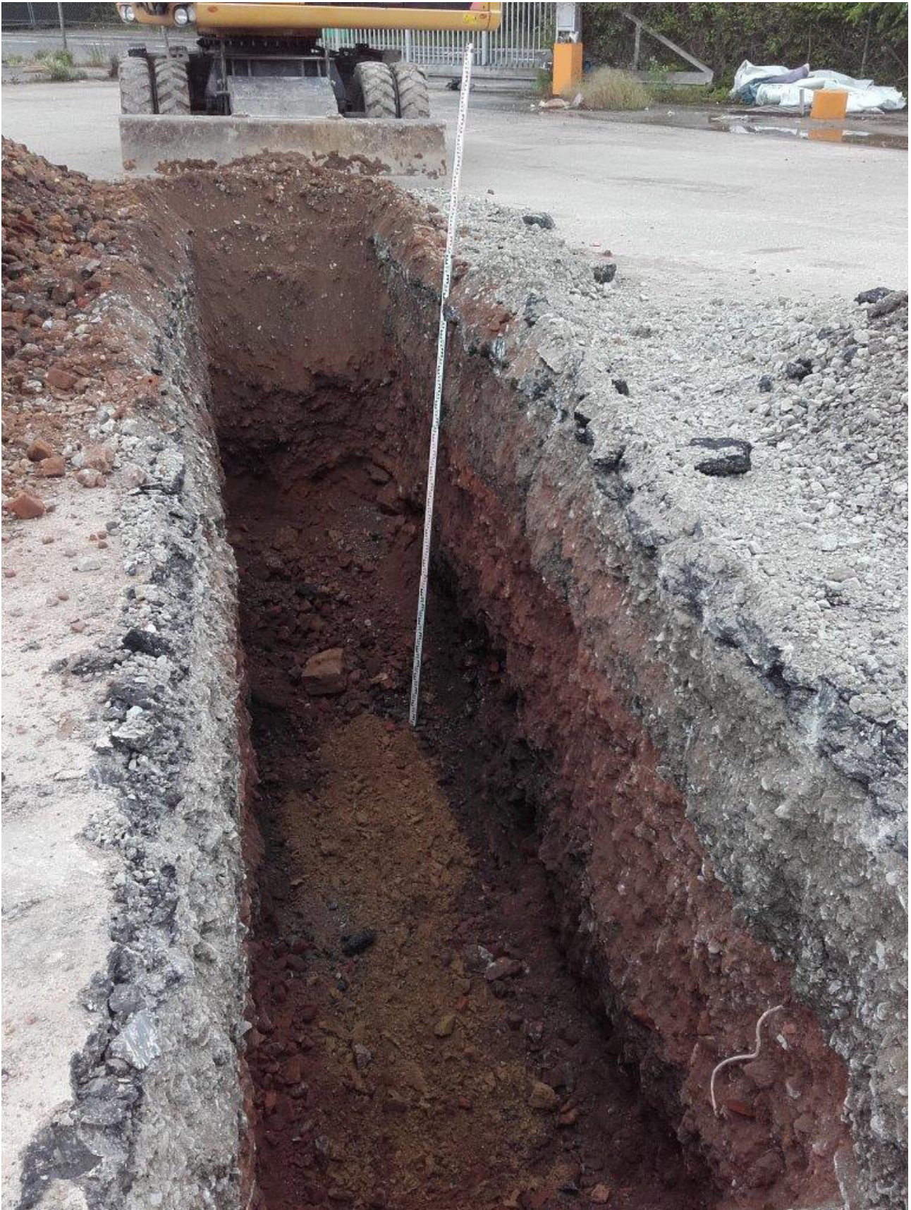
Bild 10: Schürfschlitz m-n (Blickrichtung nach Südost in Richtung n)
