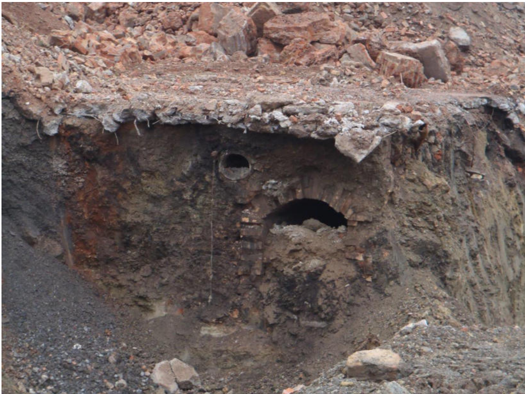
Bild 14: Verfüllter Kanal an Südseite Keller Maschinenhaus (Blickrichtung nach Westen)
