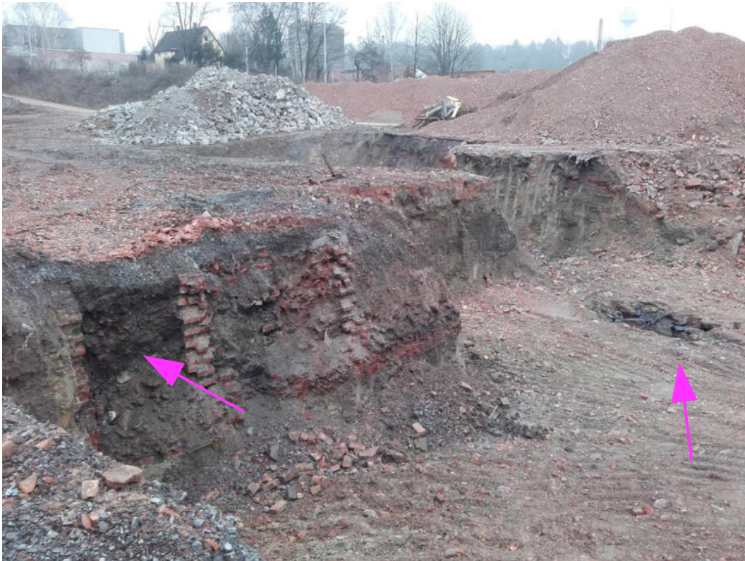
Bild 13: Blick auf Keller Maschinenhaus (Blickrichtung nach Südosten) mit WP NE-Ecke Kesselhaus (links) und Sumpf (RKS 79A)
