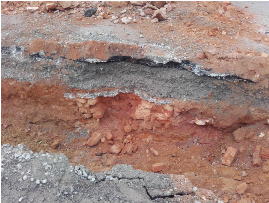
Bild 12: Schürfschlitz e-f mit querendem Rauchgaskanal (verfüllt)
