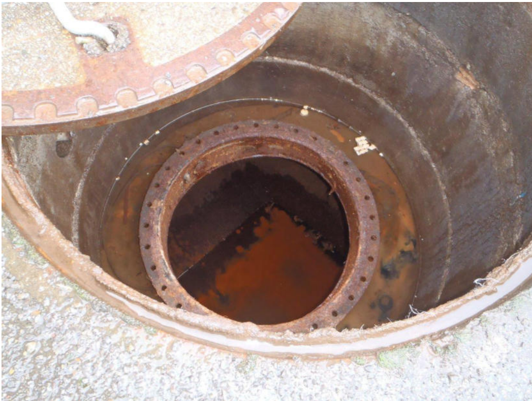
Bild 16: Geöffneter Domschacht stillgelegter Heizöltank an Nordseite Jobcenter Ziegeleistraße 12
